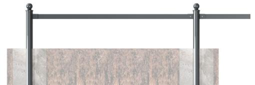
**2.** Standpfosten im Fundament positionieren. Beton hineingeben, Pfosten ausrichten.
